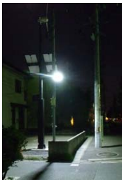
名取市役所前施工例
