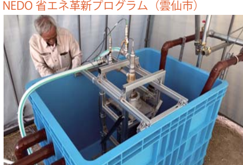
スケール抑制と高効率の熱交換を実現 長崎県小浜温泉にて R3 年 3 月 宮戸地区復興再生多目的施設として整備
