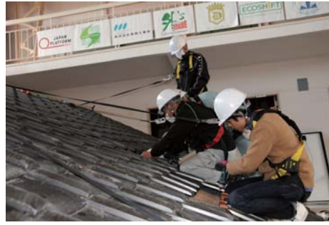
太陽光発電システム施工 基礎実習 H25 年 11 月 北海道にて環境・エネルギー産官学連携セミナー参加
